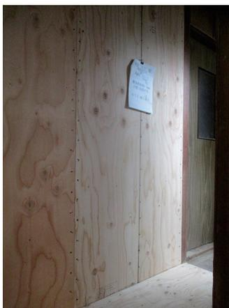
構造用合板で補強した例
