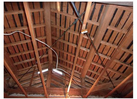
天井内部に鉄性のブレスを設置した補強例
