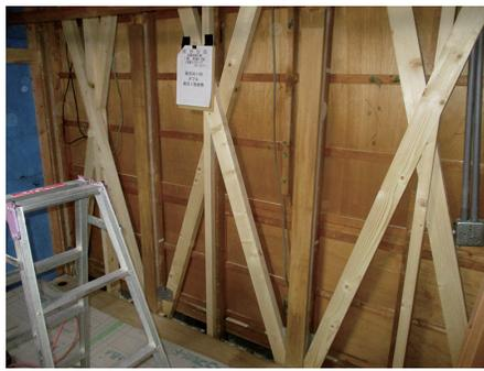
筋交いを設置して補強した例
