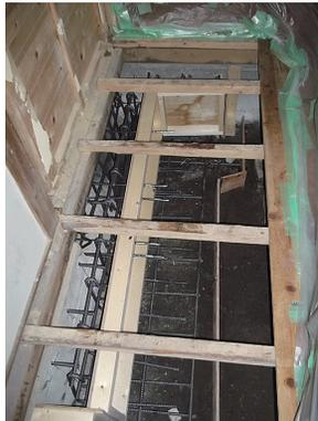
既存基礎に沿って新設基礎で補強(コンクリート打設前)した例
