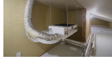
吸排気同時に行う全熱交換換気システム 第1種換気 花粉や埃をしっかりキャッチ、屋外の新鮮な空気を 室温に近づけて室内に取り込むから省エネ効果大
