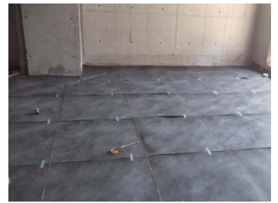
電磁波対策のシートと銅線を設置
